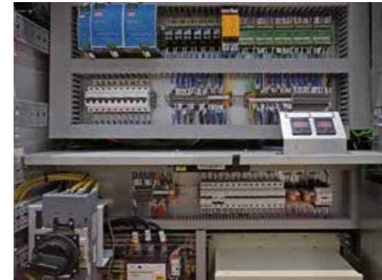
电箱采用欧洲设计标准，防护等级高，质量可靠。电箱排布上下强弱电分离。
